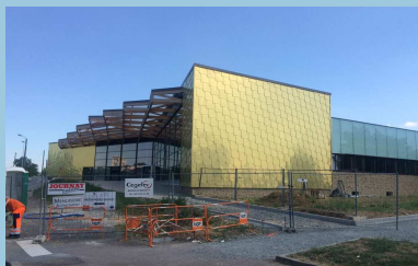
Médiathèque de Belleville (69) Mission : étude conception et d'exécution Architecte : Christian SCHOUVEY
