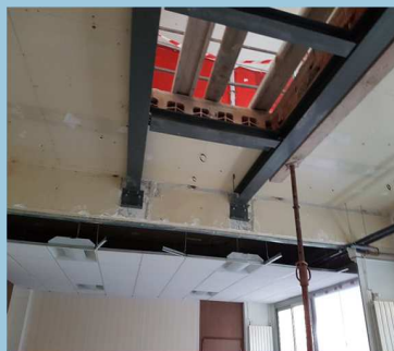
Bâtiment n°1 de SANOFI à Maison Alfort (94) Mission : étude d'exécution de renforcement Maître d'ouvrage : SANOFI
