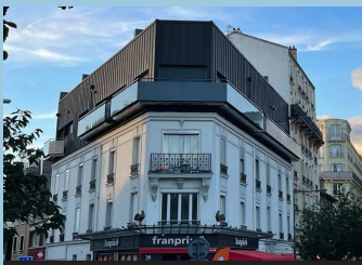
Surélévation en bois et métal à Issy-les-Moulineaux (92) Mission : étude d'exécution Maître d'œuvre : Bio Teknik Consulting
