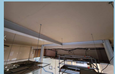
Bâtiment n°11 de SANOFI à Maison Alfort (94) Mission : étude d'exécution de renforcement Maître d'ouvrage : SANOFI
