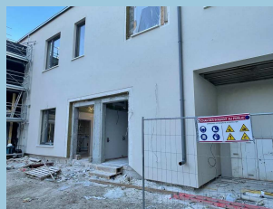
Groupe scolaire Bonnefant à St-Germain-en-Laye (78) Mission : étude d'exécution Architecte : JOLY & LOIRET
