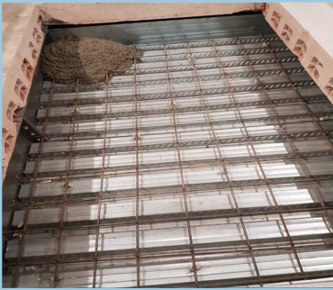
Bâtiment n°1 de SANOFI à Maison Alfort (94) Mission : étude d'exécution de renforcement Maître d'ouvrage : SANOFI
