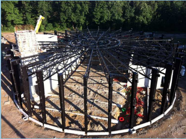
Autodrome de Linas-Monthéry (91) Bâtiment circulaire en R+2 de 38m de diamètre Mission : étude d'exécution Maître d'ouvrage: UTAC CERAM
