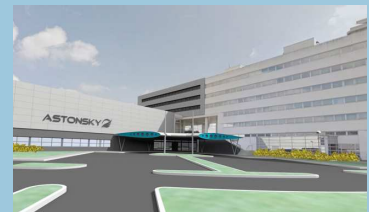
Réhabilitation terminal Alston Sky à le Bourget (93) Mission : étude d'exécution Architecte : Jean LE GALL
