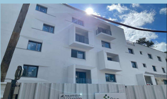
78 logements à la Celle-Saint-Cloud (78) Mission : étude d'exécution Architecte : LEIBAR & SEIGNEURIN
