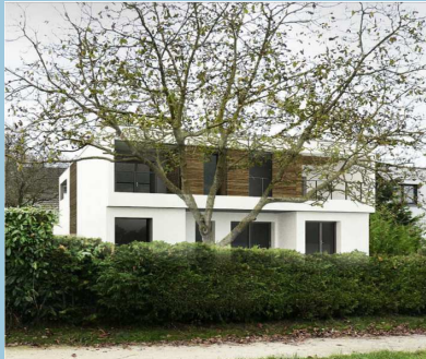
Maison individuelle à Collégien (77) Mission : étude d'exécution Architecte : SYNA Architecture
