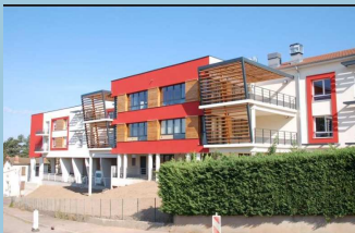
Hôpital de la Clayette (71) Mission : étude conception et d'exécution Architecte : AC3 Cropiet Architecture
