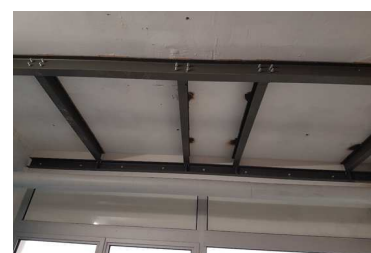
Renforcement d'un plancher existant
